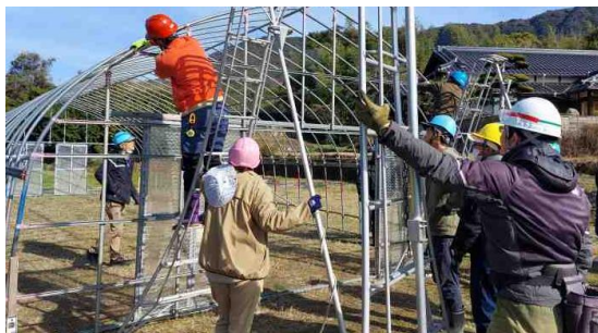
パイプハウス建設実践技術研修
