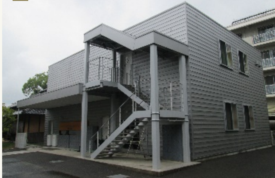
■ 新生館（移住就農促進センター）
