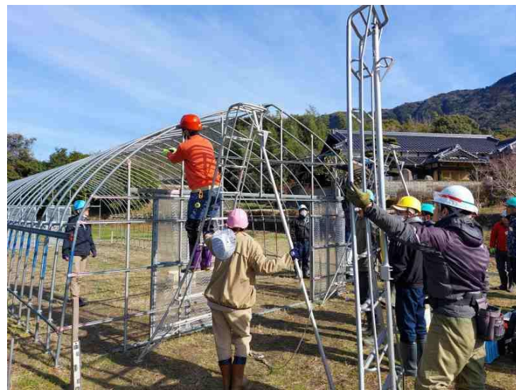
パイプハウス建設（施設園芸関係者限定）
